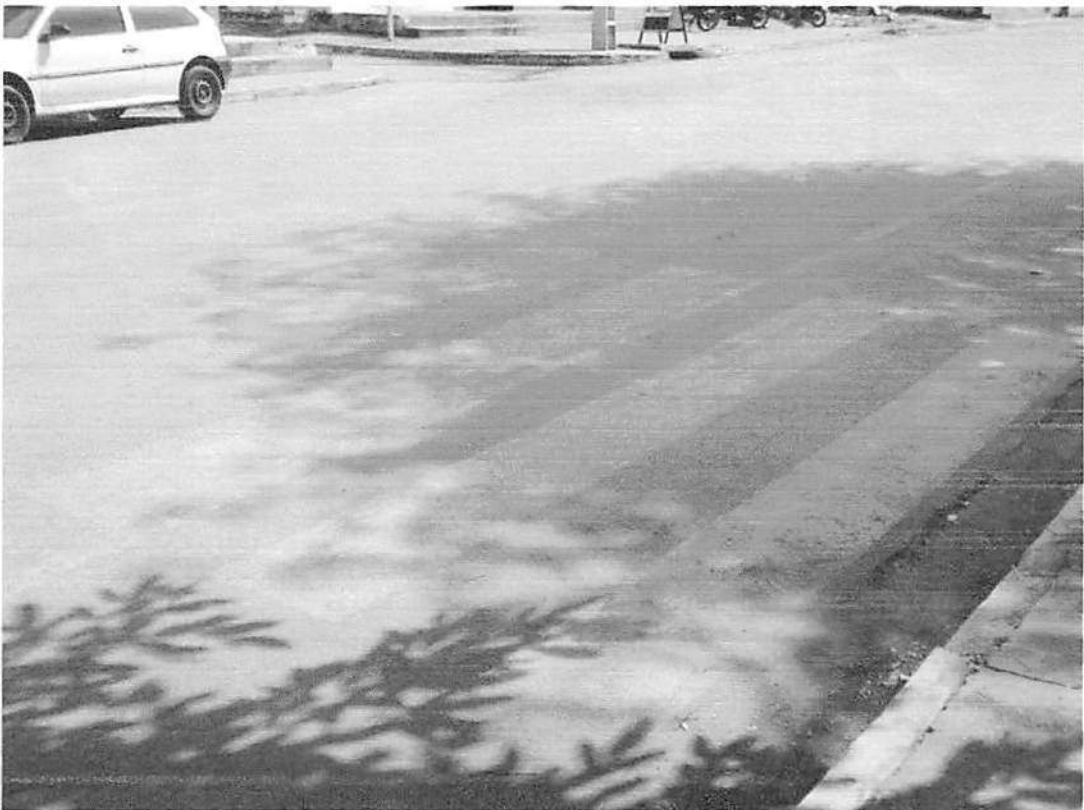
Escola São Domingos
