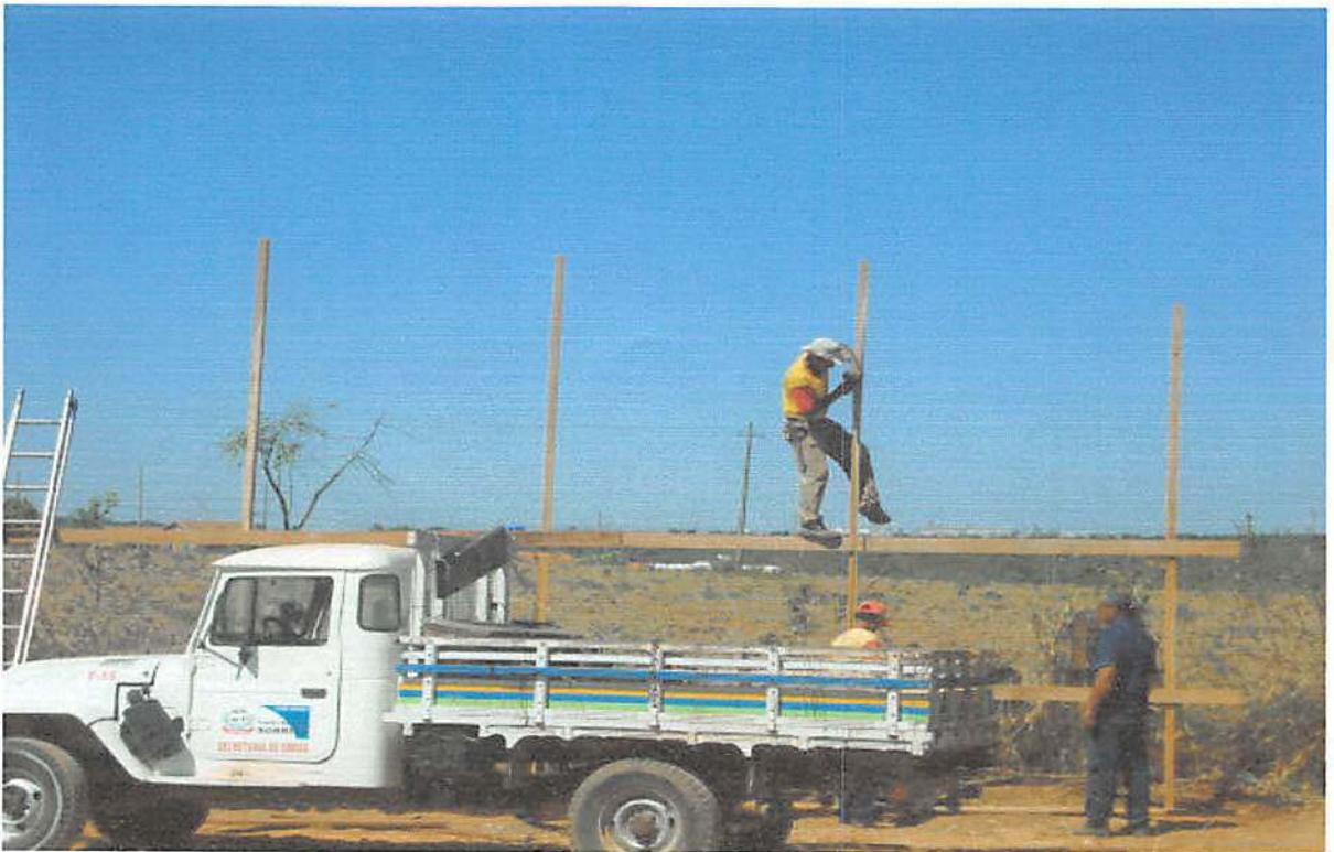
10. AV. CLAUDINO FRANCO – ENTRADA DO BAIRRO JARDIM CAROLINA – FASE DE CONTRUÇÃO.
