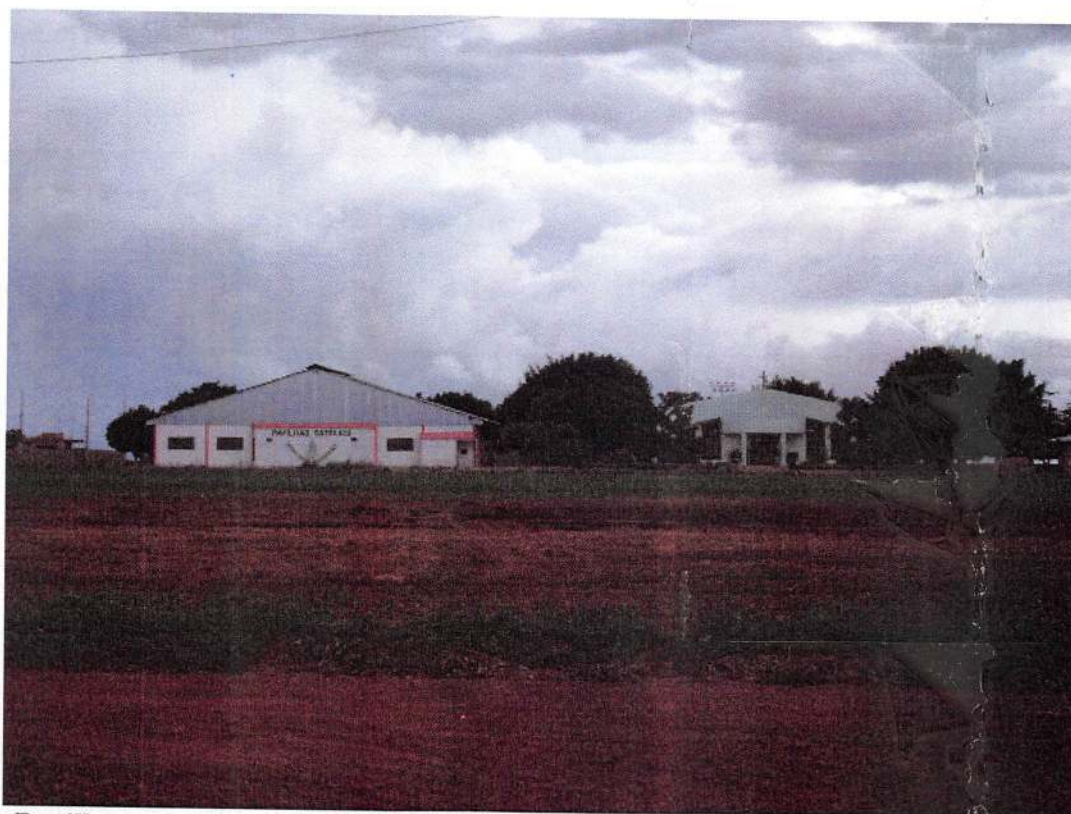
Pavilhão de festas e capela da comunidade Católica Nossa Senhora Aparecida.
