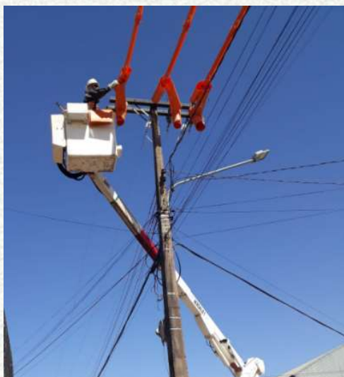
Figura 1 - Equipe de Linha Viva executando troca de condutores
