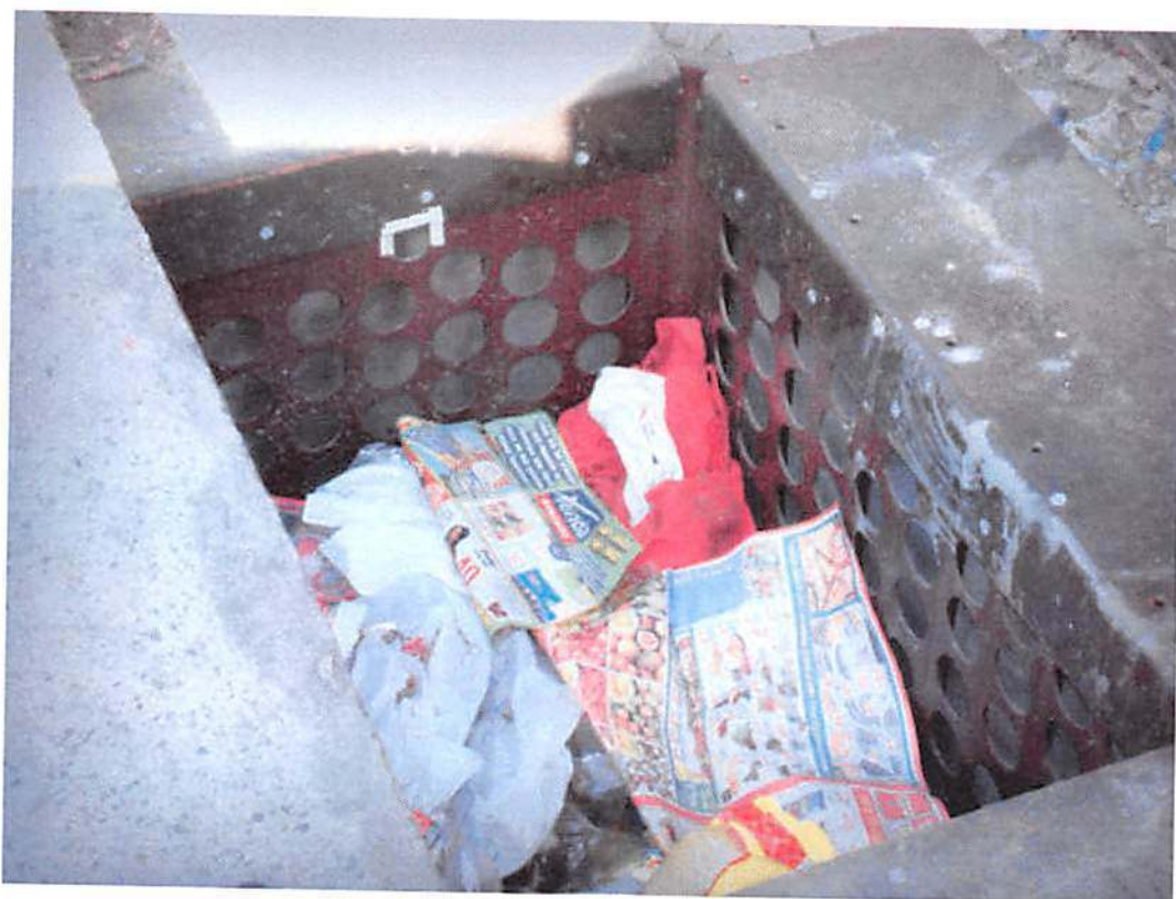
Detalhes do Eccofiltro entre o concreto e a Boca de Lobo.
