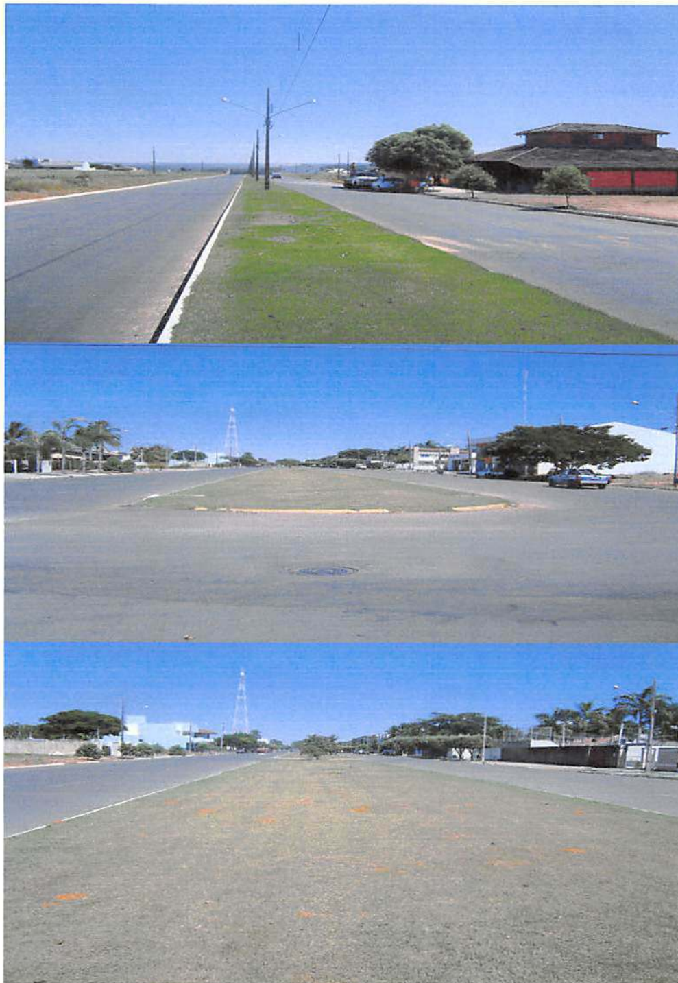
Avenidas sem arborização e ajardinamento.
